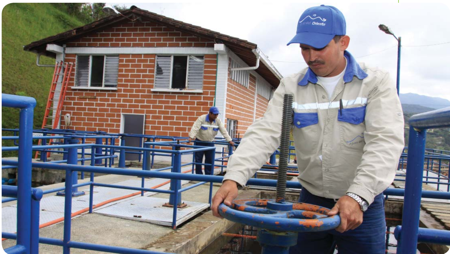
Operarios de Aguas del Oriente en el municipio de El Retiro.
