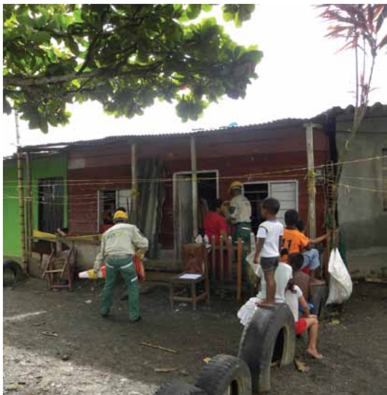
Primera instalación de energía prepago en Urabá.
