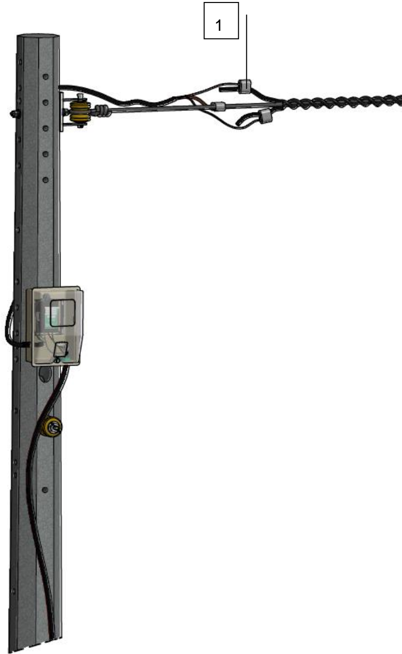
Figura 9. Instalación de un medidor bicuerpo
