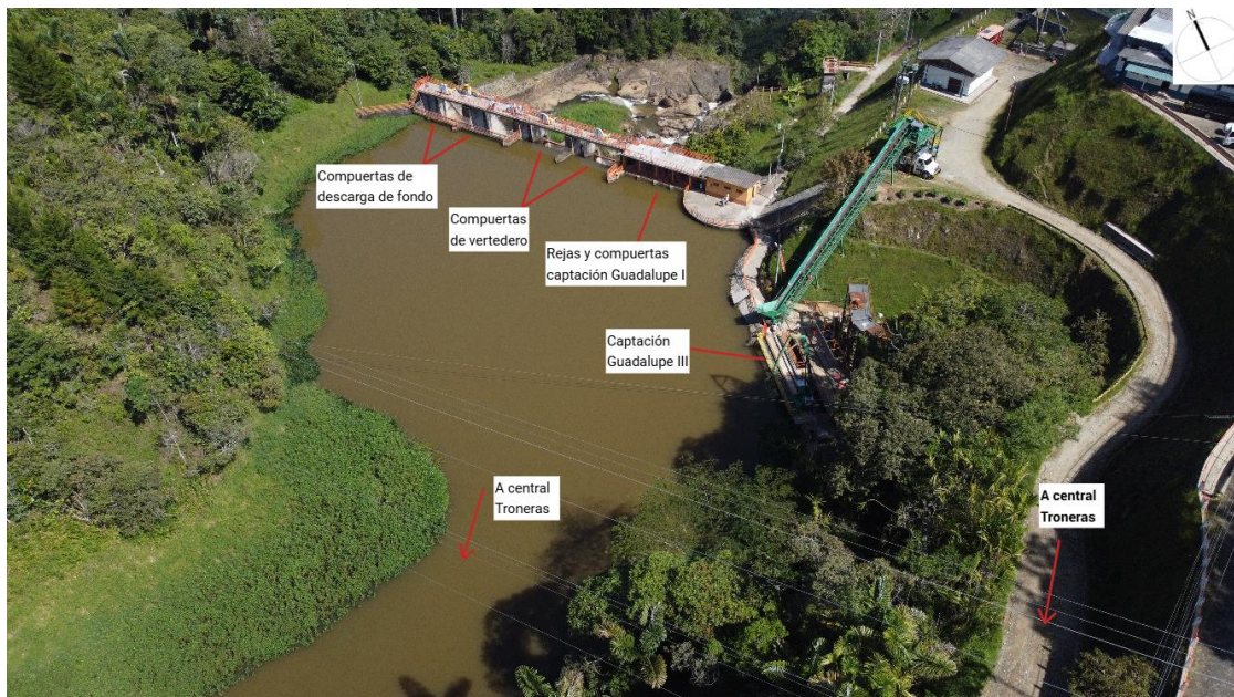
Figura 5 Localización de la Bocatoma El Salto
