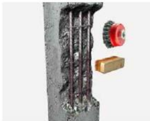
Fotografía 2 Tratamiento ante ataque por corrosión - Limpieza
