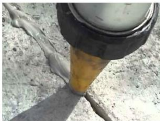
Fotografía 6 Tratamiento para fisuras – Inyección
