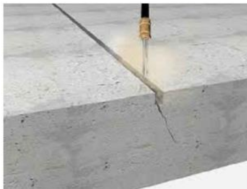
Fotografía 4 Tratamiento para fisuras – Limpieza
