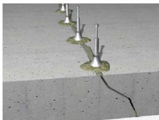
Fotografía 5 Tratamiento para fisuras – Puertos de entrada
