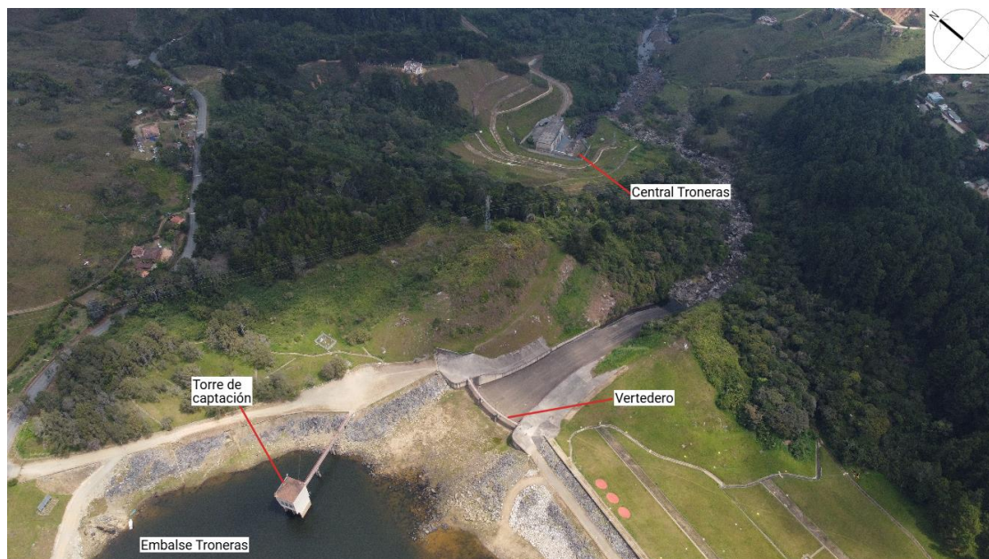
Figura 4 Localización de las estructuras a intervenir en la central Troneras
