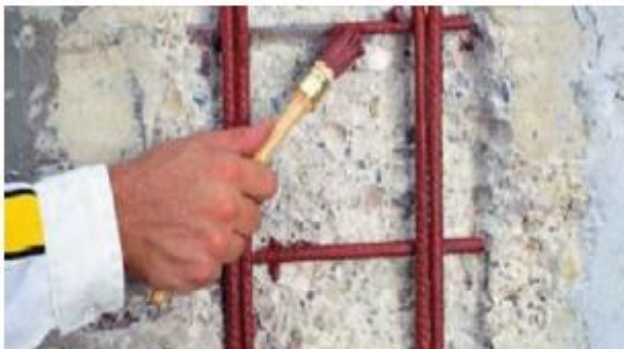
Fotografía 3 Tratamiento ante ataque por corrosión – recubrimiento anticorrosivo
