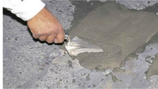
Sellado de desconchaduras mediante aplicación de mortero estructural según se indica en planos
