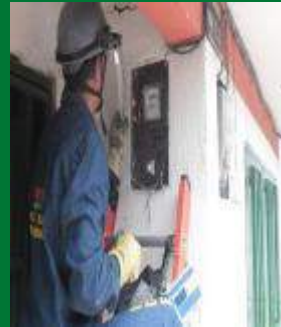
Distribución y generación eléctrica
