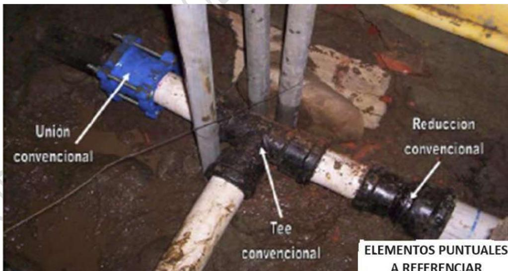
**Ilustración 76.** Esquema puntos a referenciar acueducto.
