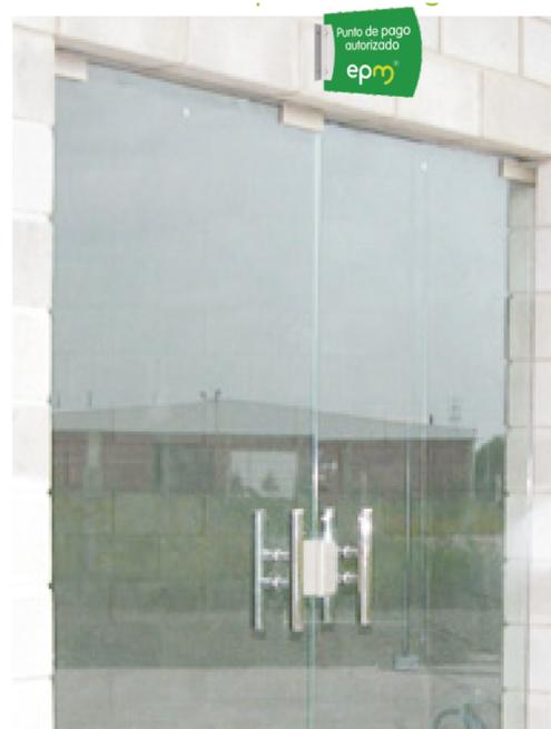
La pieza se fija con 4 chazos en el muro del lado izquierdo (FIG. 1.) junto a la puerta o vidriera de acceso, a una altura de 2.0 m midiendo desde la base (piso), en casos donde no aplique se instala en el muro del lado derecho.
