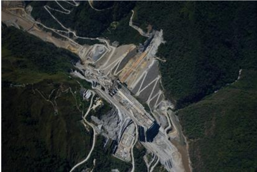
Obras civiles exteriores
