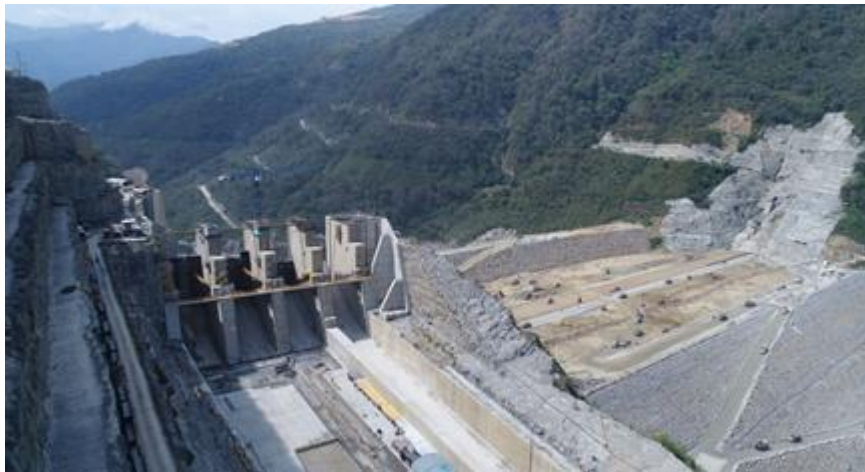
Obras civiles externas: vertedero y presa
