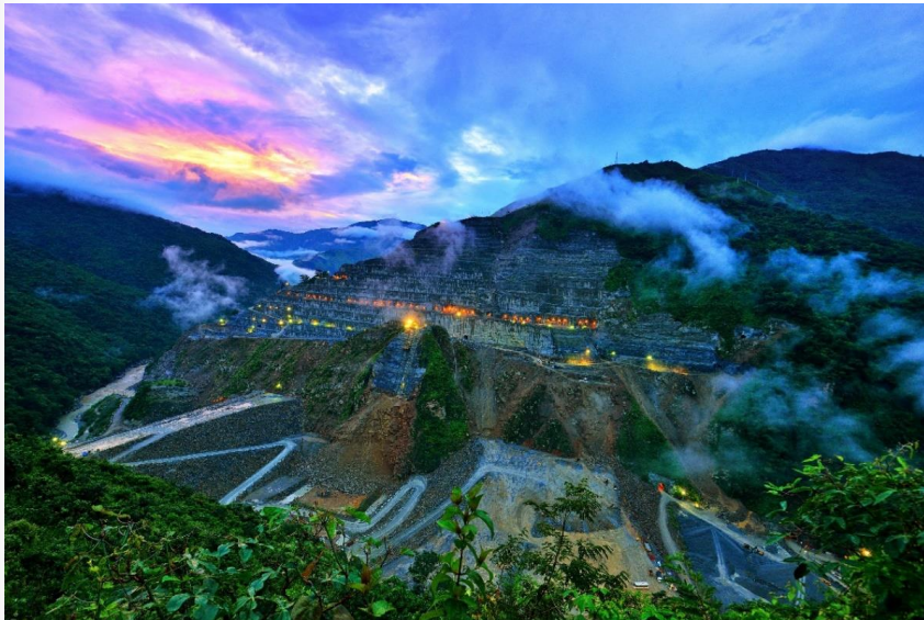
Obras civiles exteriores
