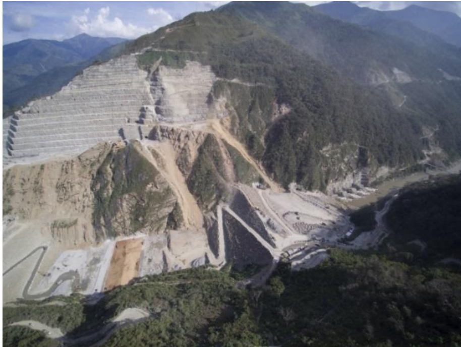
Obras civiles exteriores
