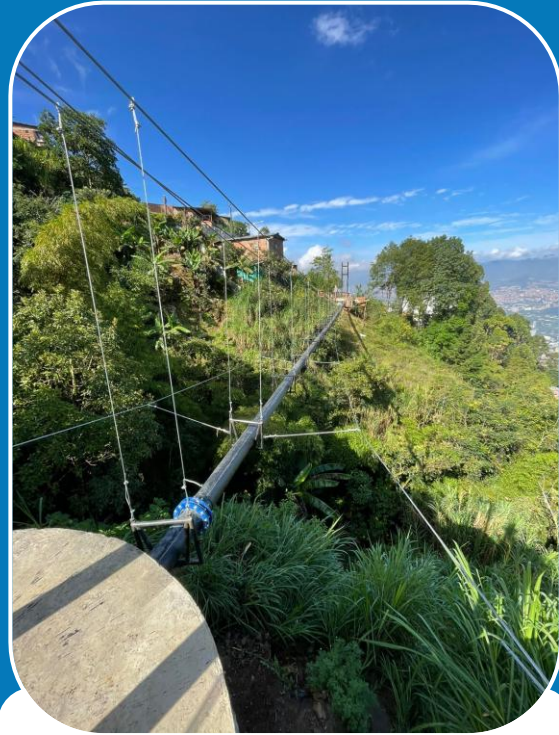
Acueducto y alcantarillado aéreo
