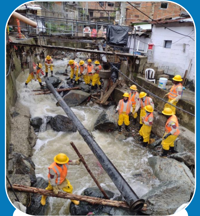
Intervención en quebradas
