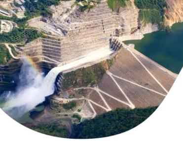
descarga intermedia y, de allí, hasta el cuenco del vertedero para reincorporarse aguas abajo al cauce normal del río Cauca.
