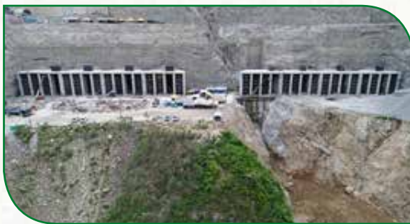
Estructuras de captación
