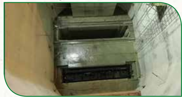
Pozo de compuertas 5
