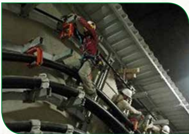
Tendido del cable monopolar de la fase C de la unidad 4.
