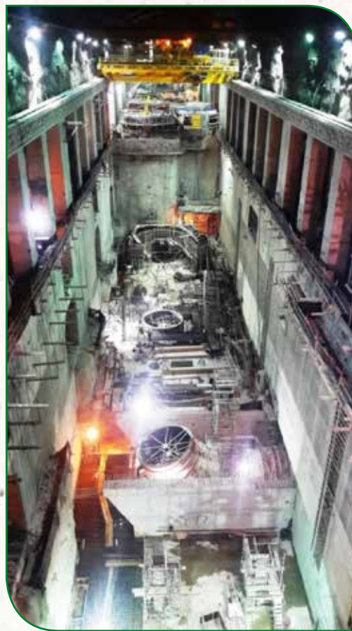
Casa de máquinas - Sur
