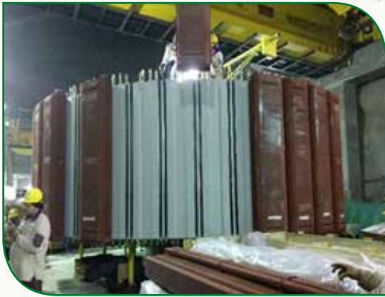
Rotor U4 – Montaje de polos.
