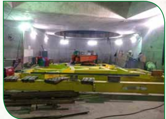
U4- Posicionamiento de equipo de mecanizado.
