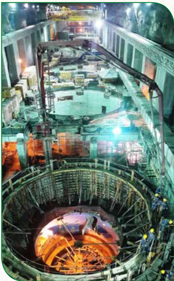
Casa de máquinas - Norte
