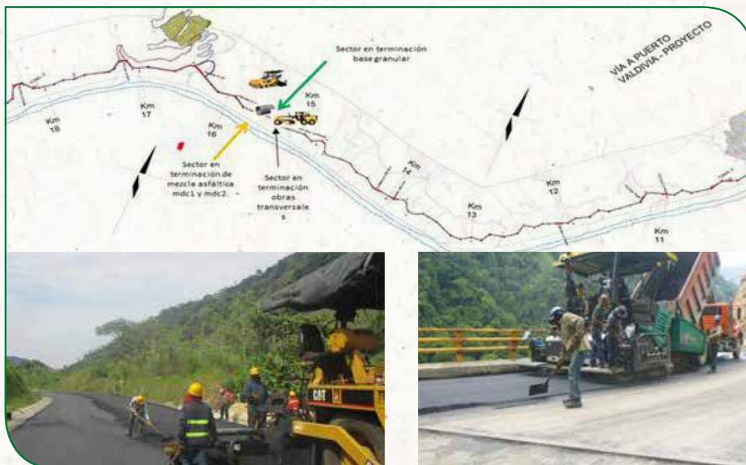
km 4+886/5+243 – Colocación de mezcla asfáltica MDC-2 km 14+926/946 – Colocación de mezcla asfáltica MDC-2.
