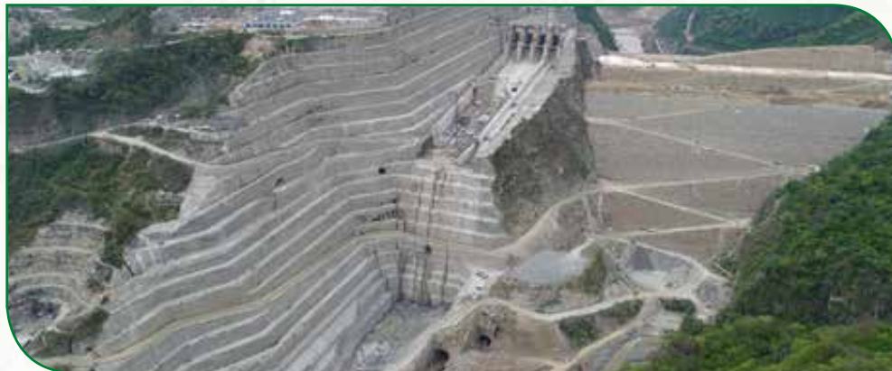
Aspecto de la presa y el vertedero
