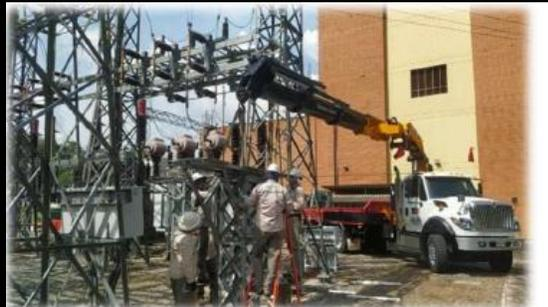
Montaje de estructura para Potenciales de Barra 44kV
