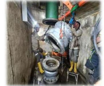
Montaje válvulas pozo seco sistema de refrigeración.
