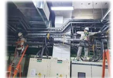
Tendido de cableado de potencia servicios auxiliares
