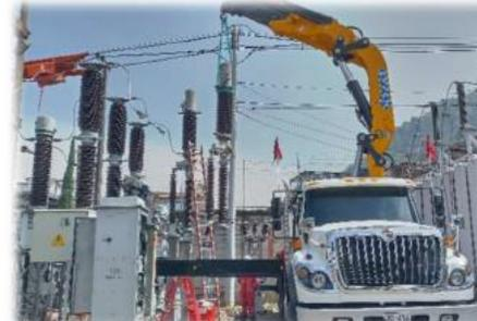
Desmontaje del interruptor existente en la BT1 110kV
