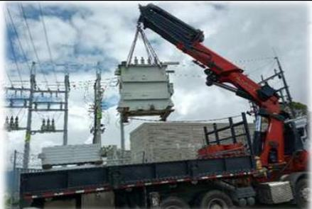
Cargue de transformador en grúa para llevar a subestación Castilla
