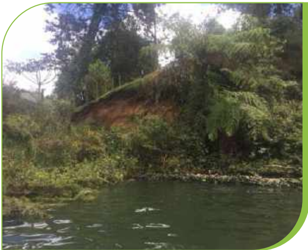
Imagen 1. Material vegetal removido por deslizamiento del talud.
