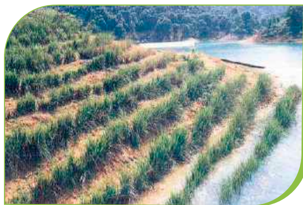
Imagen 5. Condiciones de trabajo del vetiver en reservorios de agua o embalses. (Vetiver system for dam, pond and lake bank stabilization, 2017. Recuperado de: https://www.vetiver.org/ )
