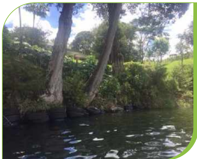
Imagen 4. Protección existente con llantas.
