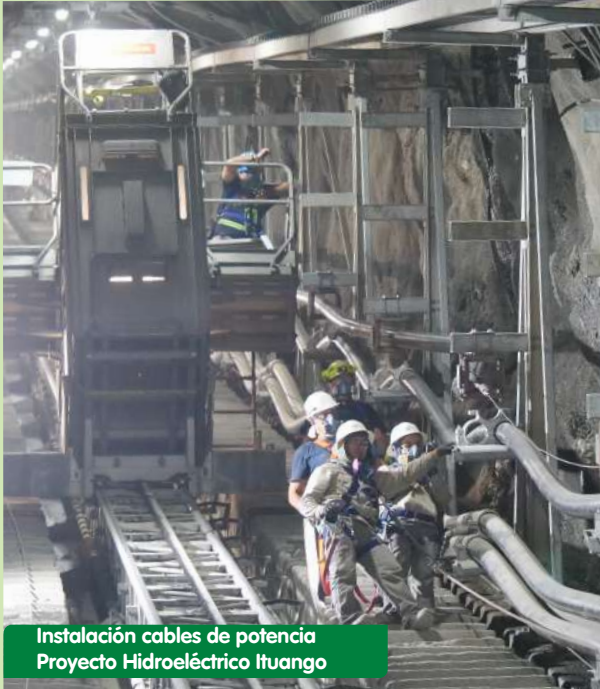
Ingreso transformador de potencia a casa de máquinas
