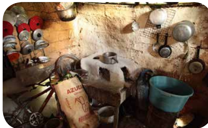
Mejoramiento de cocina, antes y después ya en construcción - Santa Rita de Ituango 2014
