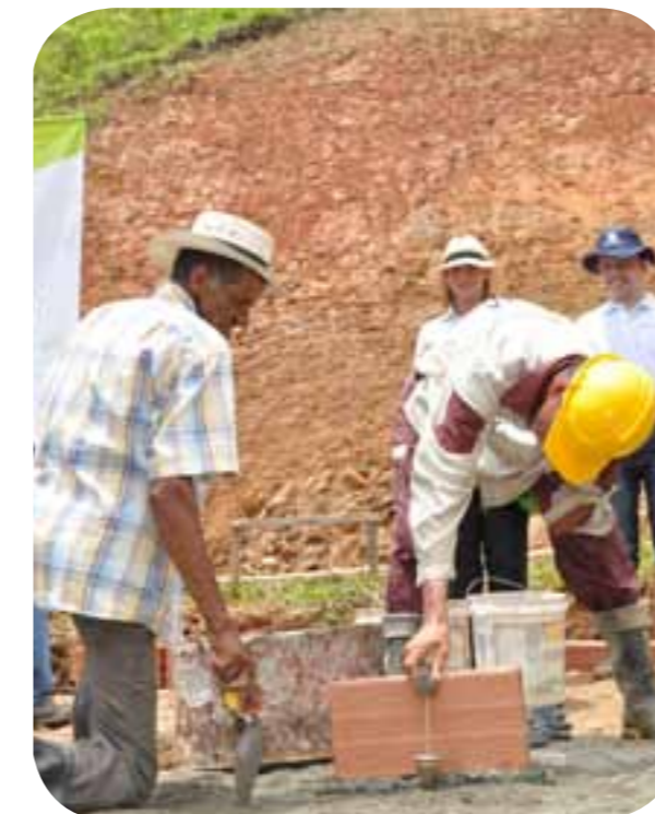
Don Rafael, y su hijo Joaquín, instalando el primer ladrillo de lo que será su casa nueva.
