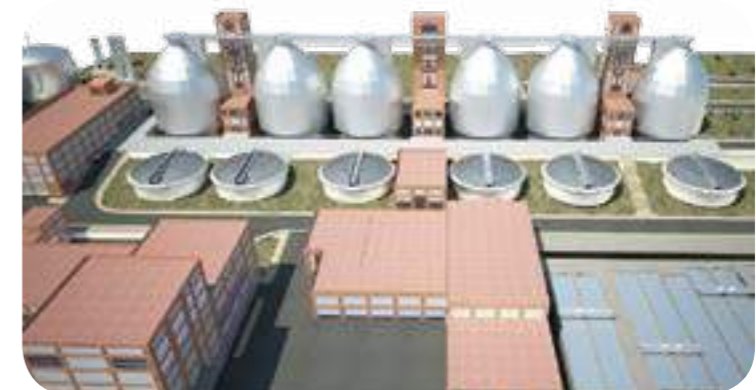
Digestores de lodos
