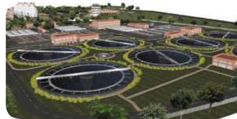
Tanques de sedimentación secundaria
