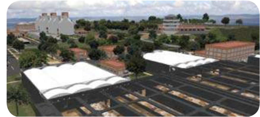
Tanques de aireación
