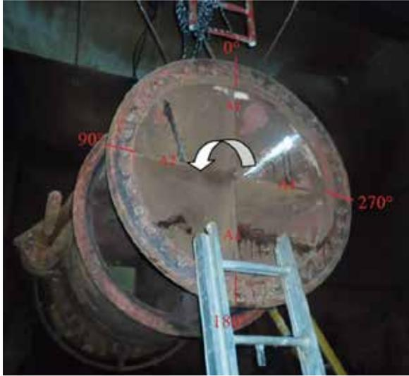
**Imagen 3.** Identificación alfa-numérica de las cuatro aletas en la Válvula Howell Bungler
