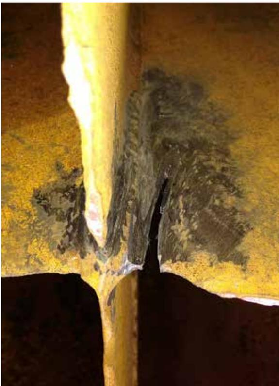
Imagen 8. Corrección de fisura entre aletas 1 y 2
