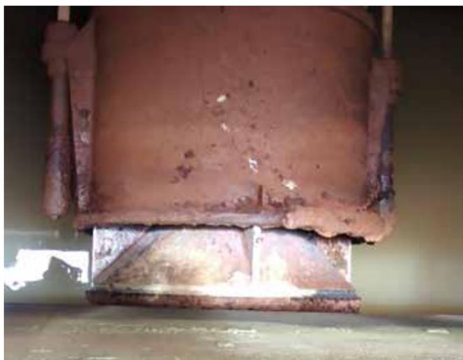
**Imagen 2.** Válvula Howell Bungler de la Presa Miraflores de EPM
