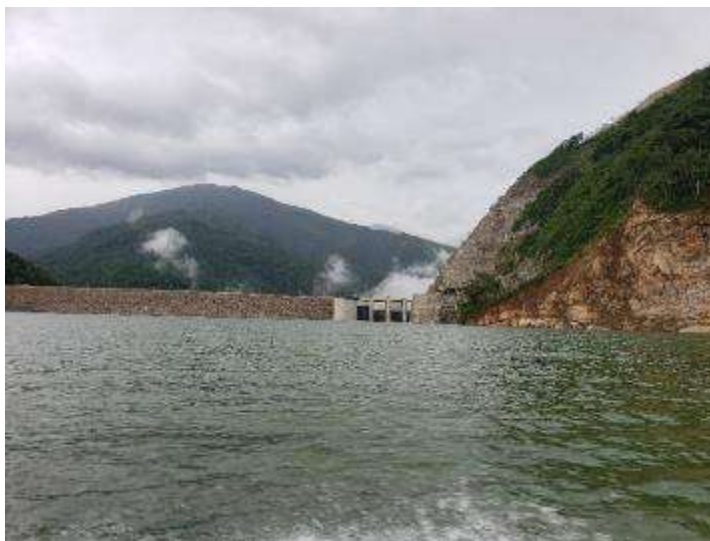
Fotografía 56. Vía que sobre la cresta del muro de presa.
