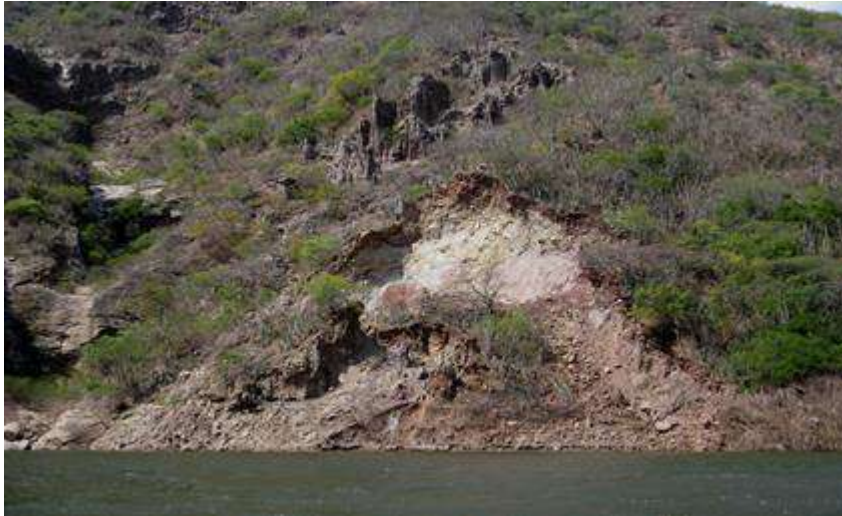
Fotografía 66. Desprendimiento en la orilla del embalse Topocoró, en zona de valle encañonado del río Sogamoso. Proyecto Hidrosogamoso.
