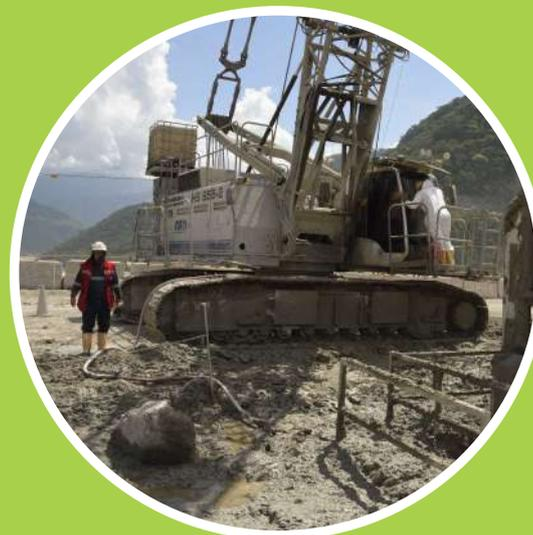
En el núcleo de la presa, avanza la construcción de la pantalla plástica o corta-flujo, a cargo de la empresa Soletanche. Los trabajos se realizan de manera vertical, en paneles de 2,5 metros de ancho x 1 m de espesor y 38 m de profundidad. Esta pantalla plástica tiene 500 metros de largo en promedio (entre estribo y estribo). La pantalla dará garantía de mayor impermeabilidad a la presa.
