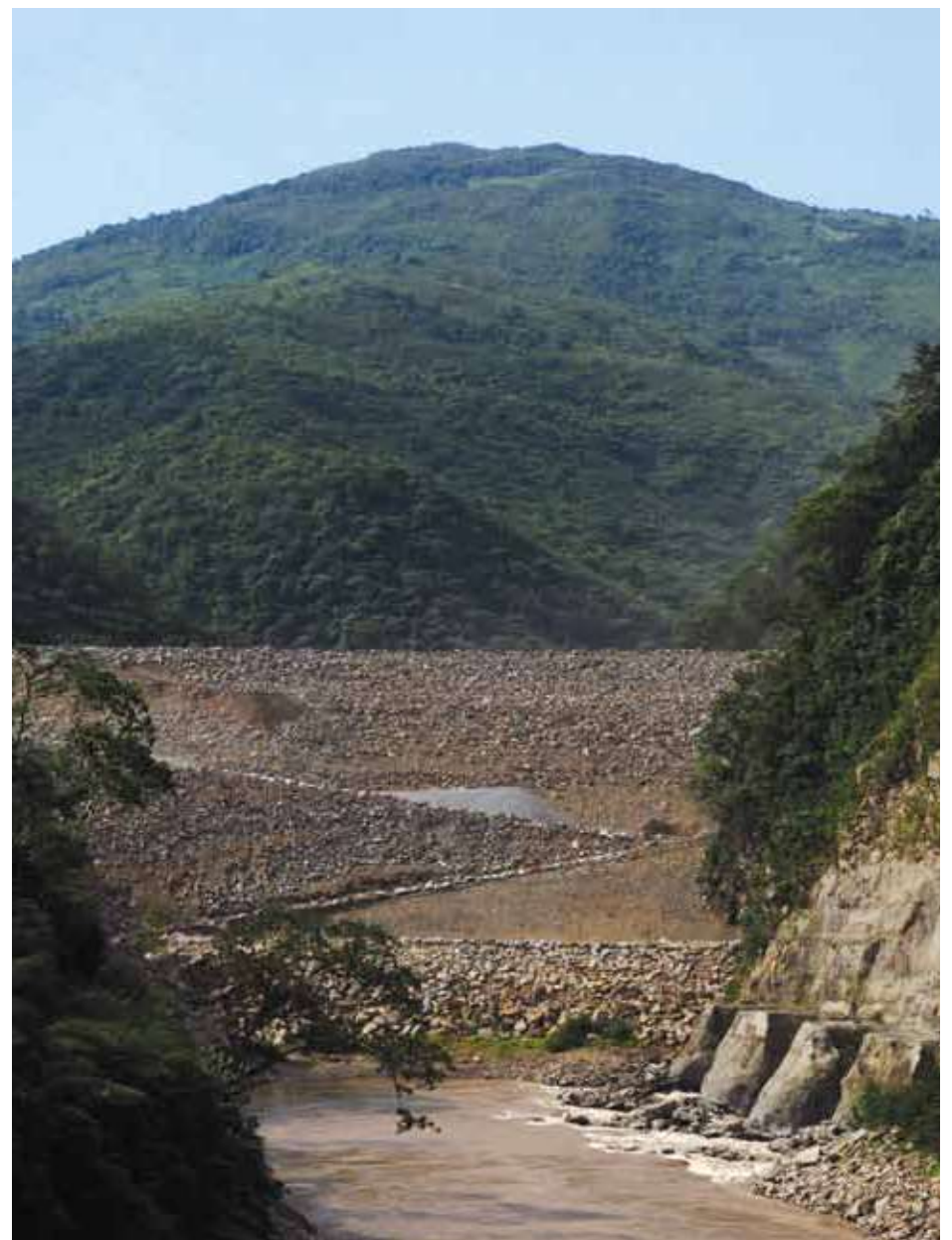
El sistema de desviación del río Cauca, del cual se pueden apreciar las cuatro entradas a la derecha, permitió iniciar la construcción de la presa.
