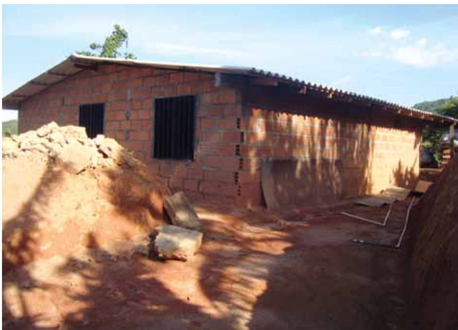
Así va la construcción de la casa que, a punta de caña, está construyendo para ella y sus hijos.
