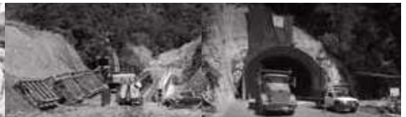
La vía Puerto Valdivia – sitio de presa 8
