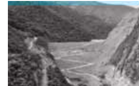
Avanzan las obras civiles 10
