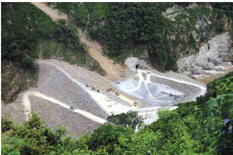
Desde las montañas cercanas se puede ver cómo van cobrando altura las obras de la presa.
