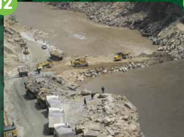
La construcción de la preaiguá y el desvío del río Cauca, permitirán secar un área aproximada de casi un kilómetro del lecho del río para dar paso a la construcción de la presa que tendrá 225 metros de altura.
