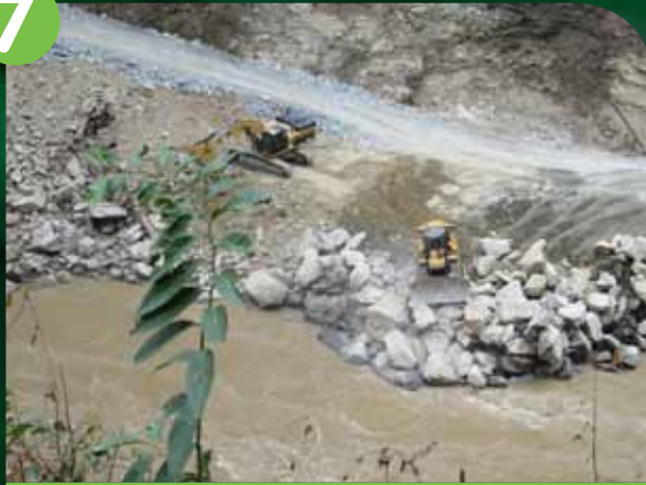
Mediante el lanzamiento de roca de gran tamaño al río, comienza la construcción de la preaiguá.
