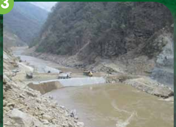
La construcción de la preaiguá y el desvío del río Cauca, permitirán secar un área aproximada de casi un kilómetro del lecho del río para dar paso a la construcción de la presa que tendrá 225 metros de altura.
