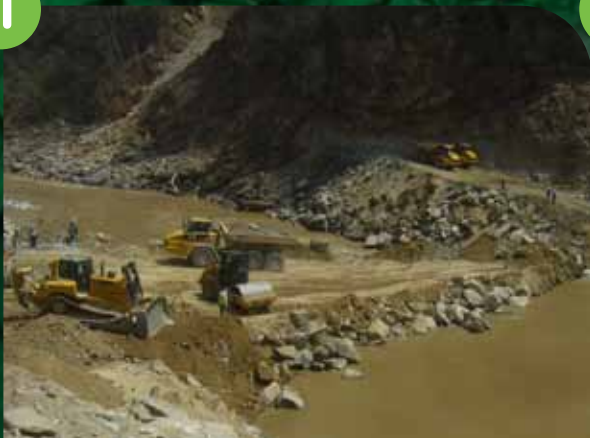
La construcción de la preaiguá y el desvío del río Cauca, permitirán secar un área aproximada de casi un kilómetro del lecho del río para dar paso a la construcción de la presa que tendrá 225 metros de altura.
