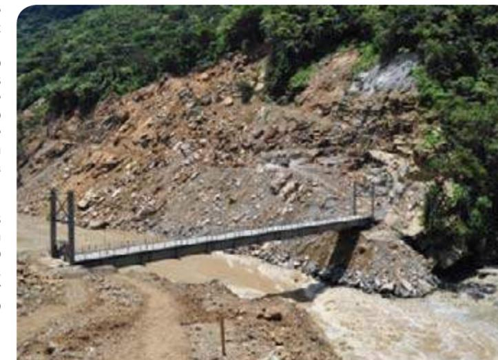
Puente metálico temporal sobre el río Cauca en el sitio de presa.
