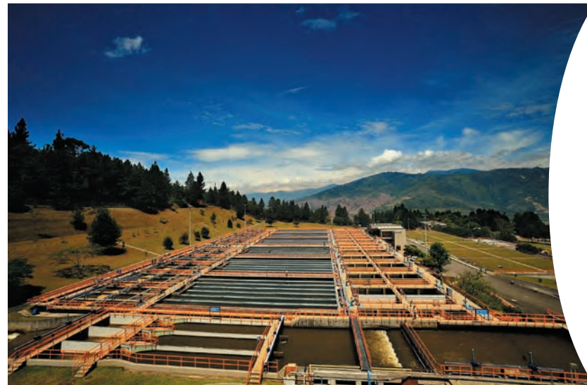
● Planta de Potabilización Manantiales.
