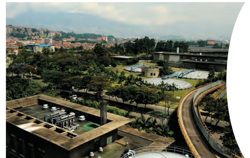
● Planta de Tratamiento de Aguas Residuales San Fernando.
