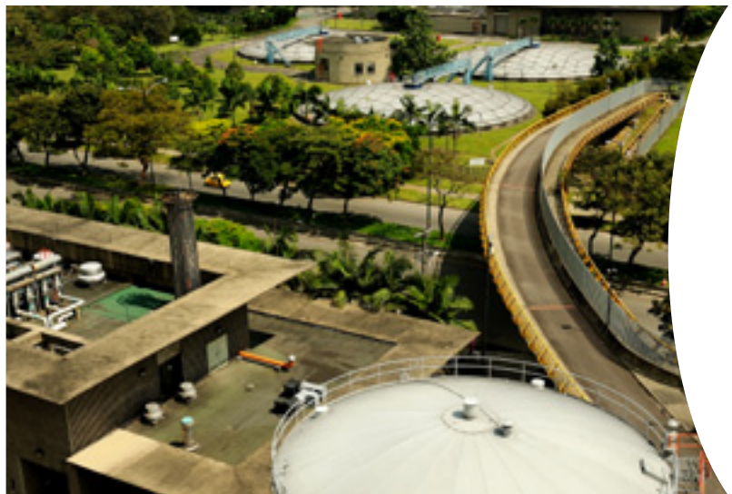
● Planta de tratamiento de aguas residuales San Fernando.
