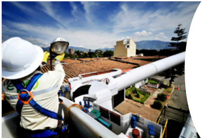
● Mantenimiento Alumbrado Público.
