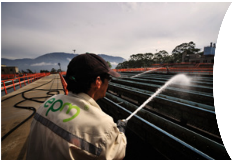
● Planta de tratamiento de aguas residuales San Fernando.
