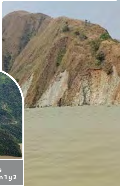
Monitoreo a taludes inestables en el embalse
