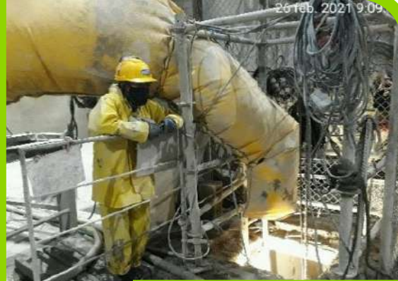
Implementación de sistema de ventilación para espacios confinados.
