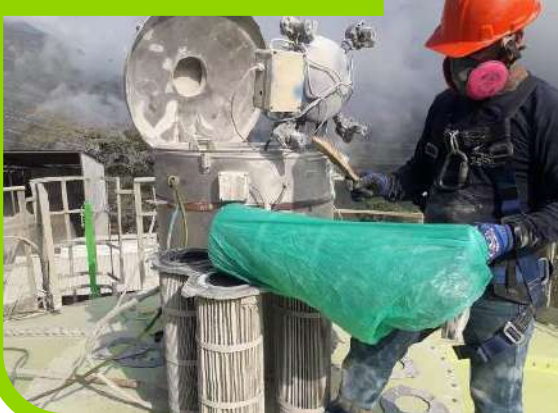
Limpeza de filtros en silos de almacenamiento de cemento.
