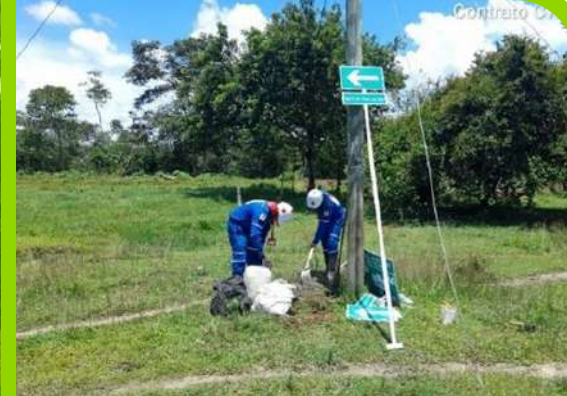
Instalación de señalética de rutas de evacuación.
