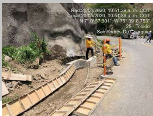
Construcción de obra hidráulica para permitir el flujo continuo de las aguas superficiales
