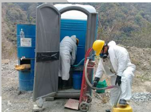
Limpieza de unidades sanitarias portátiles km 19+990
