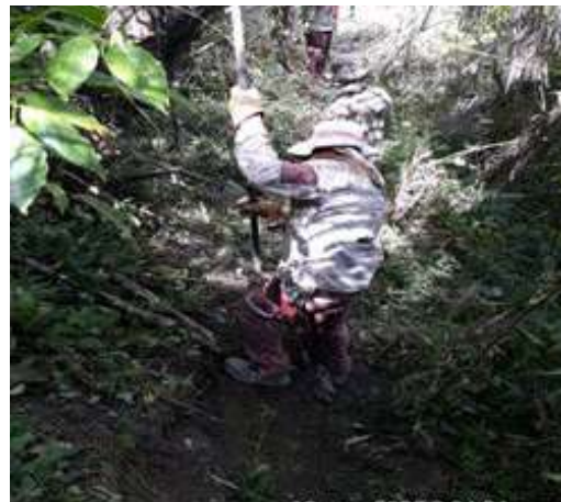
Adecuación de caminos
