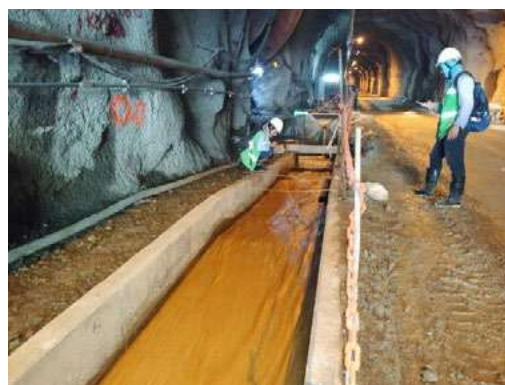
Aforo de aguas de filtración por el método del flotador
