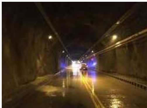
Lavado de la vía del túnel
