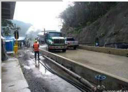
Lavado de llantas de vehículos que ingresan a vías pavimentadas
