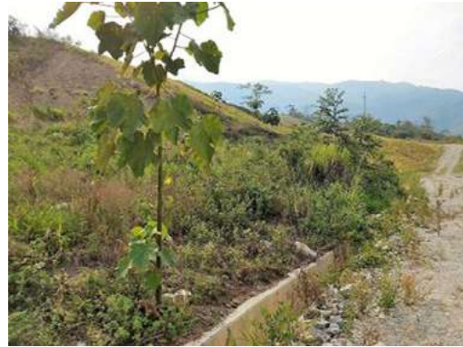
Drenajes en concreto y revegetalización
