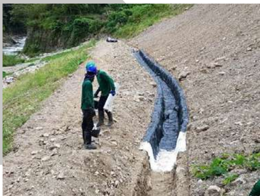
Obras de drenaje en material polimez
