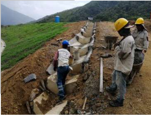
Conformación de cunetas para tratamiento de aguas superficiales
