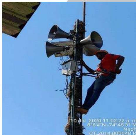
Labores de mantenimiento del sistema de alarma - Nechí
