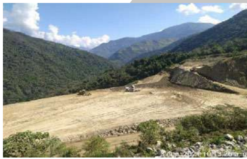
Depósito Ticuitá Sur
