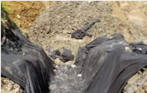
Construcción de filtrosobras de drenaje subterráneas para depósitos.
