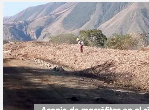
Acopio de macrófitas en el sitio.
