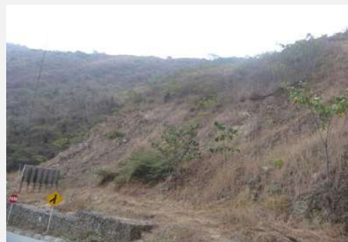
Gaviones para controlar sitio inestable.
