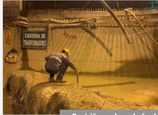
Revisión en la galería de construcción superior norte.
