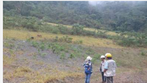
Zona de depósito Sinitavé. Conformación de bermas y taludes, y revegetalización de taludes superiores.
