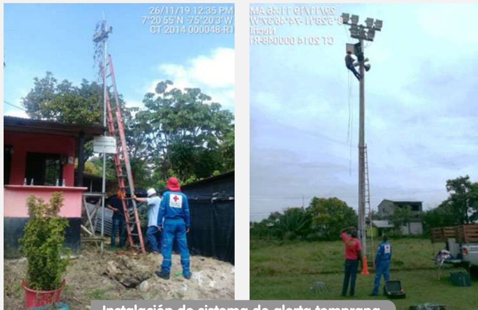
Instalación de sistema de alerta temprana.
