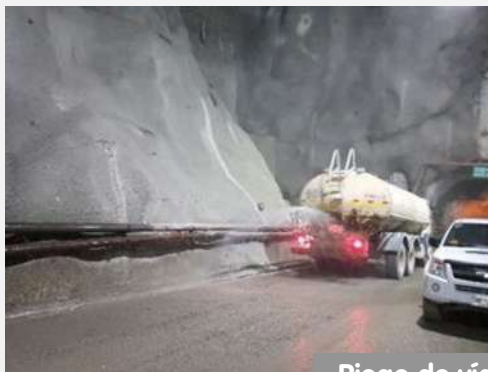
Riego de vías.
