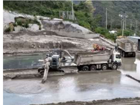
Funcionamiento de sedimentadores y trampas de grasas
