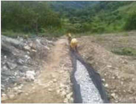
Construcción de filtros
