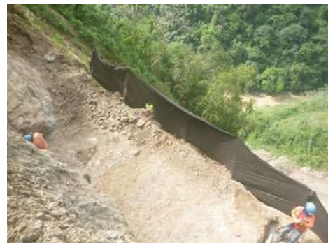
Instalación trincho para evitar arrastre de material a la ladera
