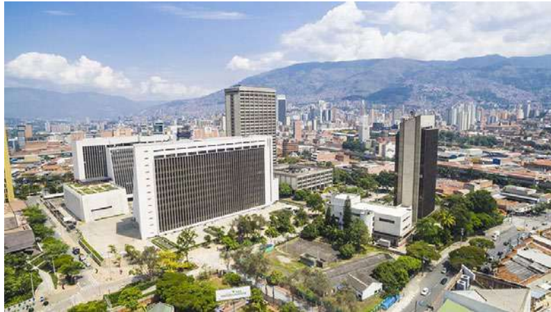
Centro Administrativo La Alpujarra.
