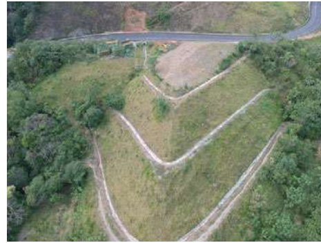
Zona de depósito con bermas, cunetas y revegetalización
