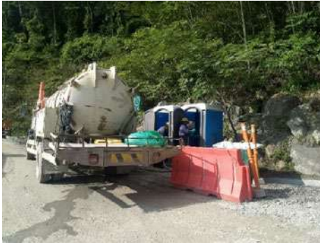
Limpieza de unidades sanitarias portátiles con carro vactor
