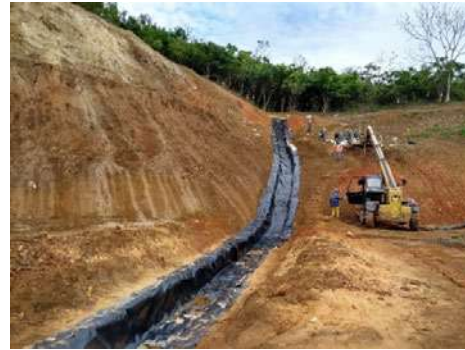
Construcción de canales
