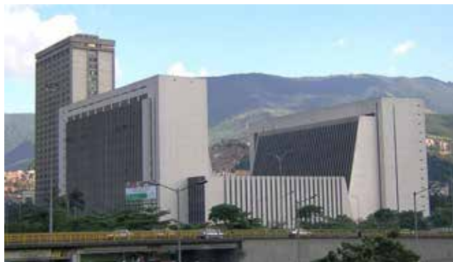
Centro Administrativo La Alpujarra. Conjunto urbanístico de edificaciones donde se encuentran ubicadas las sedes oficiales de la Alcaldía y el Concejo de Medellín, y la Gobernación de Antioquia.
