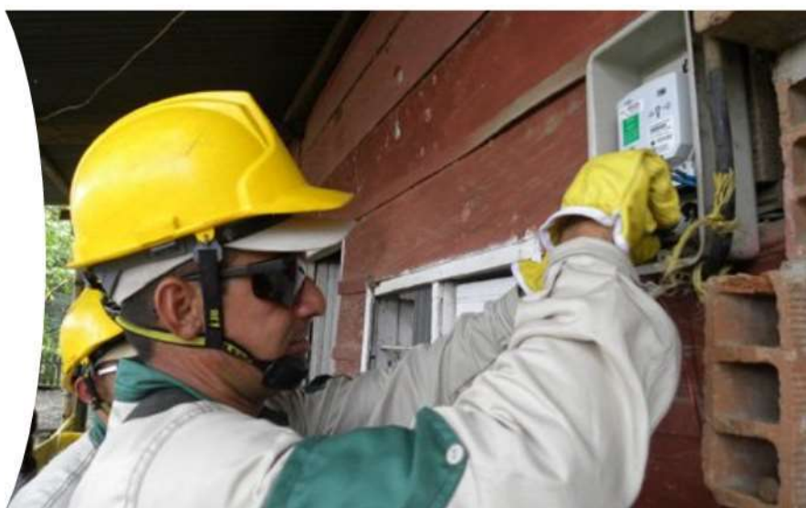
● Instalación primer medidor de Energía Prepago en Urabá.
