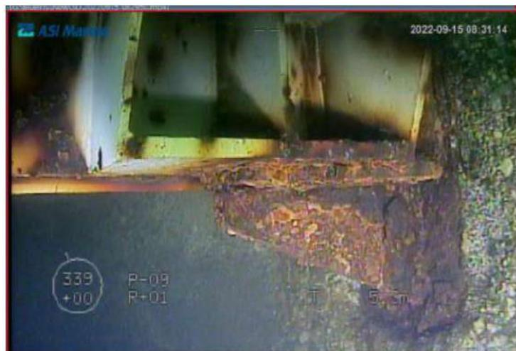
Figura 17: Soporte de compuerta corroído.
