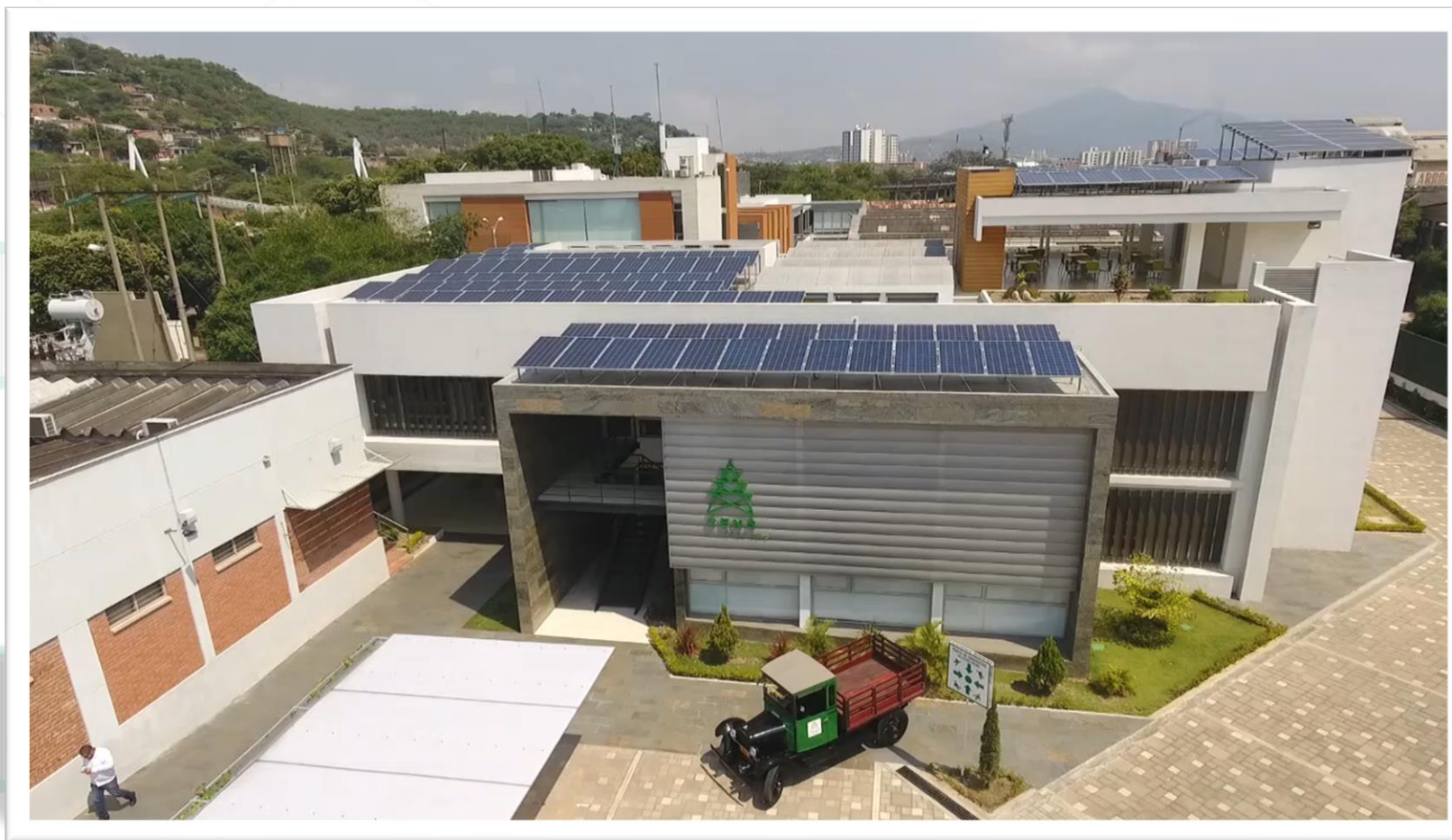
← EDIFICIO T&D - CENS CUCUTA Potencia Instalada: 50 kWp →
