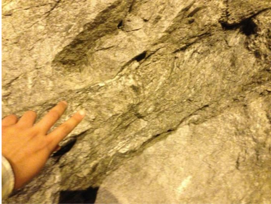
Figura 1 Fotografía de la Ref. 13. Zona de cizalle ("cizalla") con un espesor de aproximadamente 25 cm. Considerar que el material de la zona parece ser roca triturada y no es evidente un mayor espesor.
