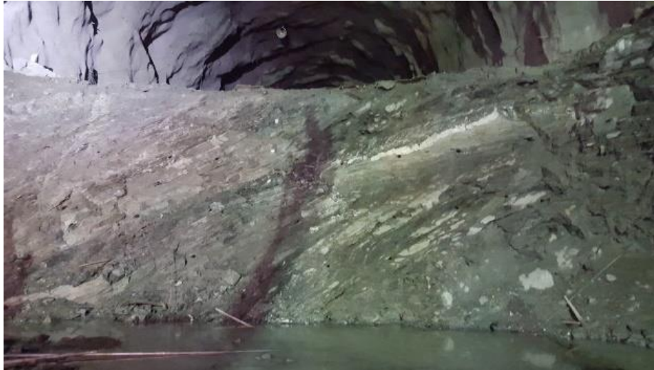
Figura 5 Fotografía se muestra el banco en la GAD en la abscisa 0 + 534.5 (tomada de Ref. 23)
