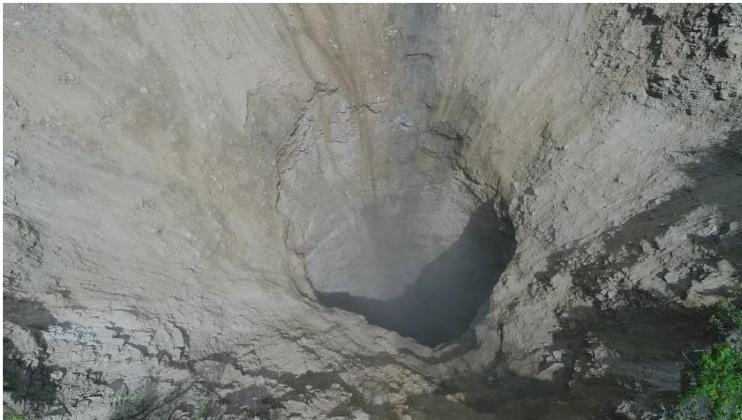
Figura 7 Detalle de la zona inferior del cráter de subsidencia (Tomada de Ref. 5)
