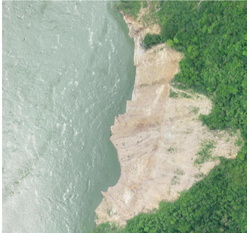
Figura 2-1 Condición actual talud desviación (enero/2021)
