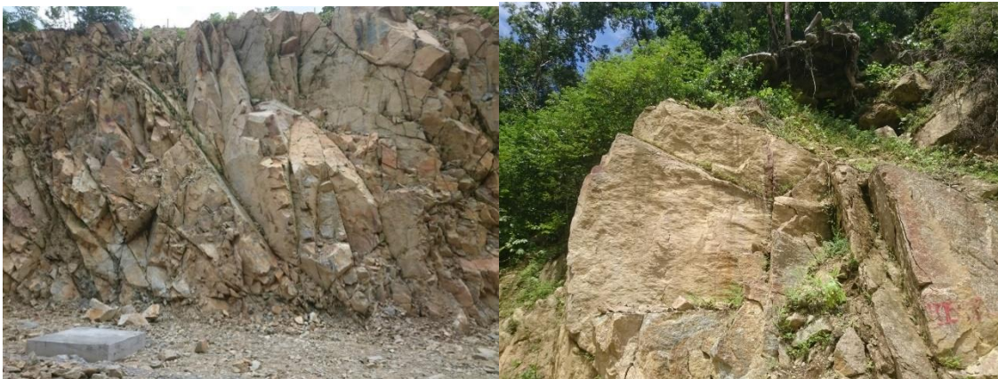
Figura 2-51 Material característico del sector km 16+050 – km 16+350.
