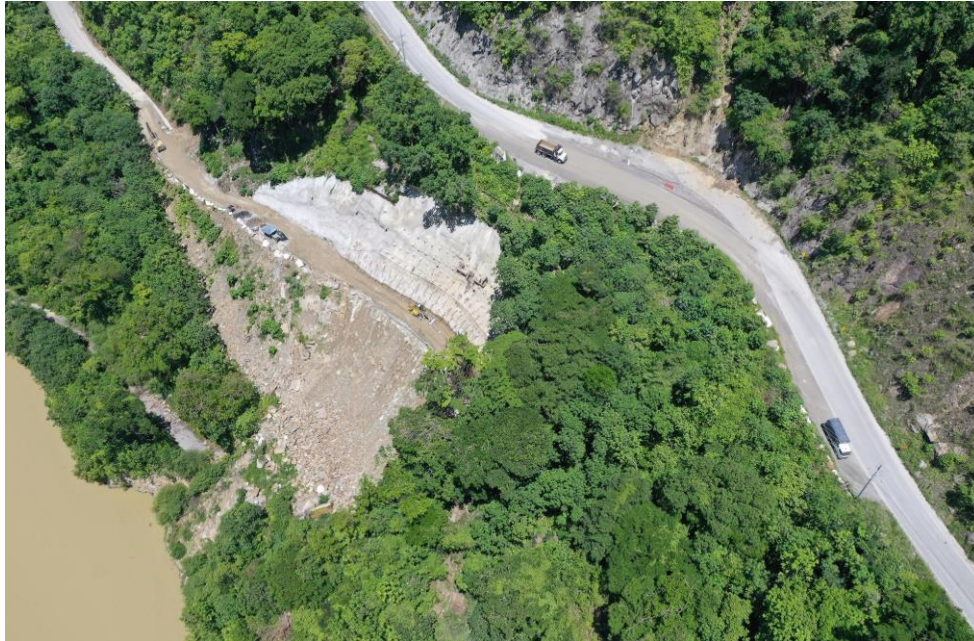
Figura 2-79 Panorámica avance trabajos en el sitio k0+900.
