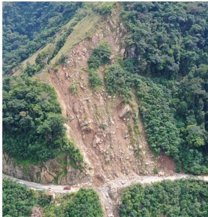
Figura 2-50 Estado actual del deslizamiento – Agosto 2020.
