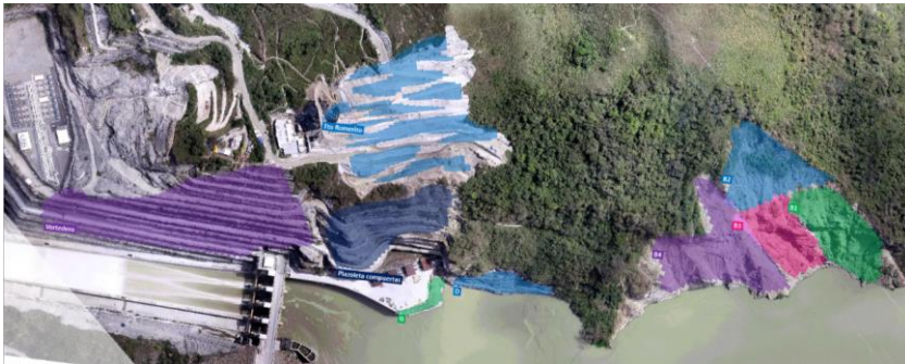
Figura 2-55. Zona de monitoreo – Margen derecha del embalse
