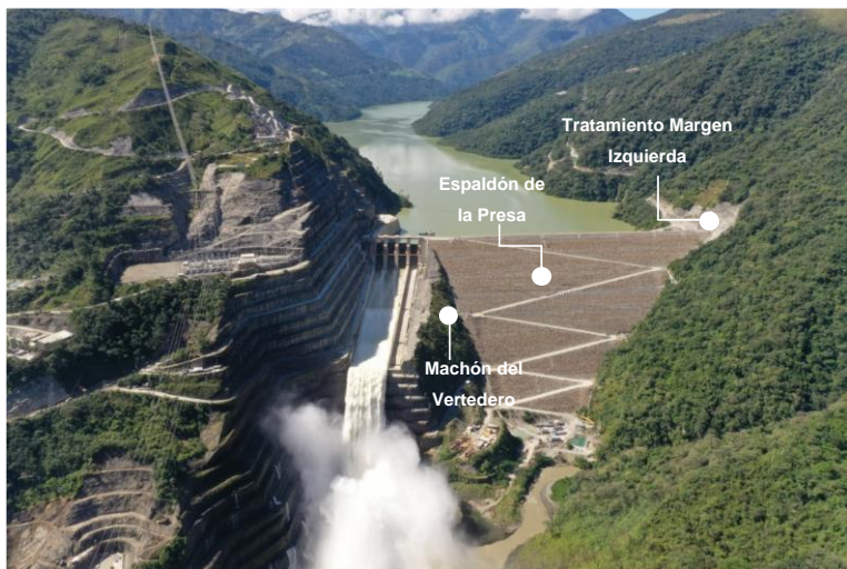
Figura 2-61. Zona de monitoreo – visual del radar.
