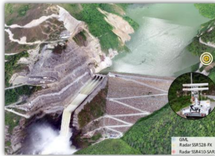
Figura 2-54. Ubicación radar SSR528 - FX.
