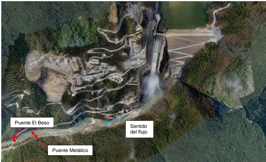
Figura 2-14. Localización Estaciones Puente Metálico y Puente El Beso.
