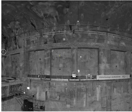
Figura 2-66. Imagen de escaneo del GML Casa de Máquinas Norte abscisa 0+078.
