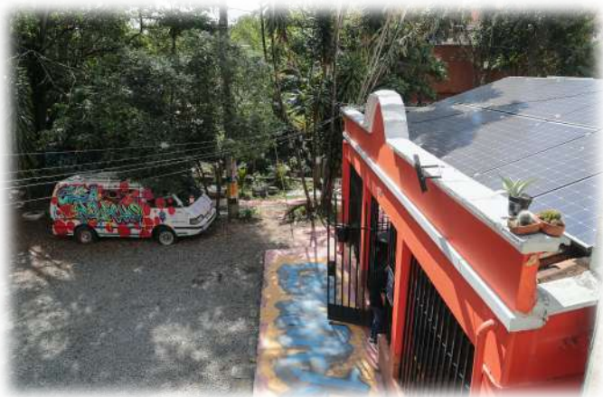
EPM avanza en piloto de paneles solares en la Comuna 13
