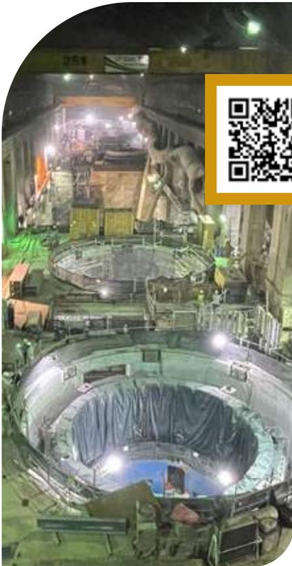
● **Avance en la reconstrucción de los túneles y pozos pertenecientes a las conducciones,** que se encargan de llevar el agua del embalse hasta las turbinas generadoras; y la **colocación de concretos e instalación de equipos principales, de apoyo y secundarios,** para las primeras unidades de generación.
