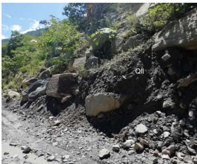
Fotografía 2-7 Lleno antrópico en la margen derecha del río Cauca, sector de descarga de la Central, tomada en octubre de 2019.
