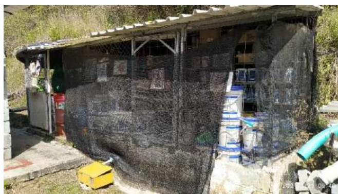
Fotografía 2-20 Dique de contención, zona superior del campamento.
