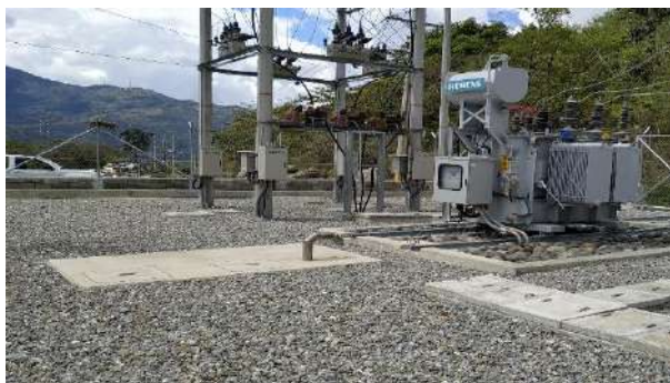
Fotografía 2-22 Transformador reductor.
