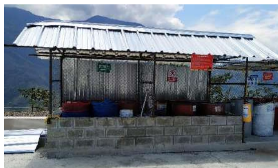
Fotografía 2-15 Dique de contención zona externa
