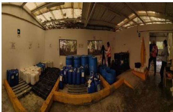
Fotografía 2-21 Dique de contención, productos de aseo y limpieza
