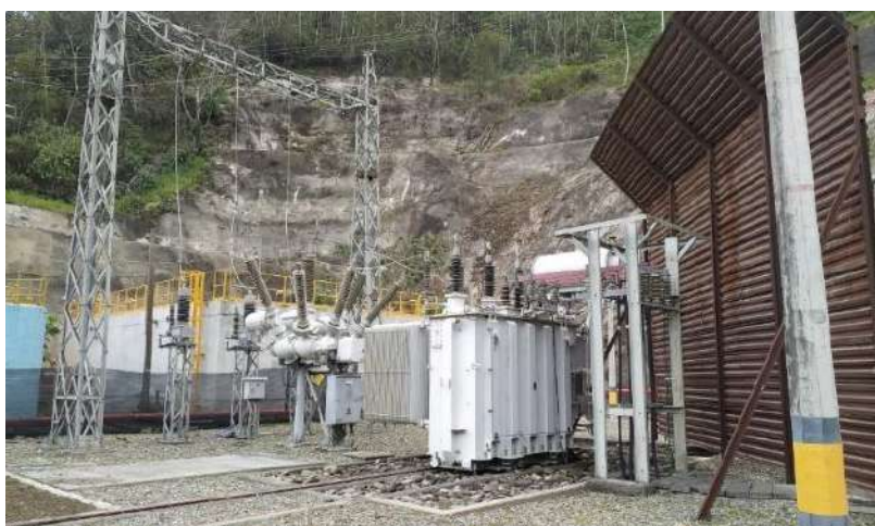
Fotografía 2-36 Transformador trifásico.
