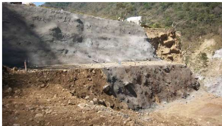
Fotografía 2-6 Conformación de taludes en material aluviotorrencial a la salida de los túneles de desviación, tomada en febrero de 2012.
