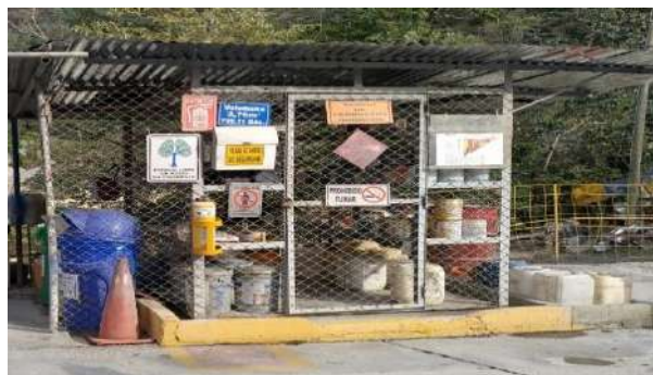
Fotografía 2-31 Dique de contención, acopio 2.
