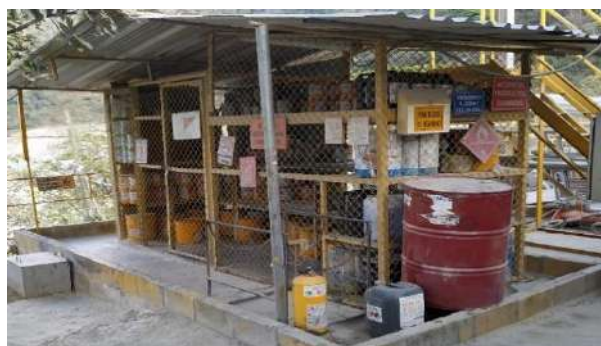
Fotografía 2-30 Dique de contención, acopio 1.
