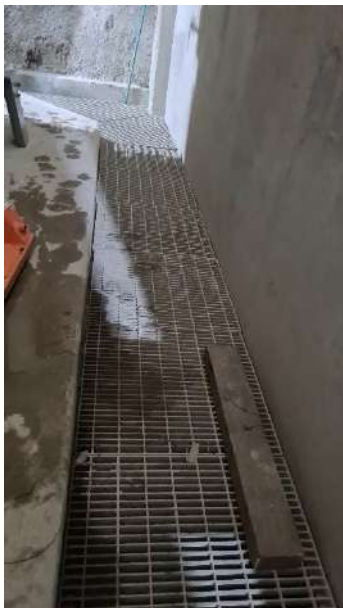
Fotografía 2-10 Cárcamos perimetrales.
