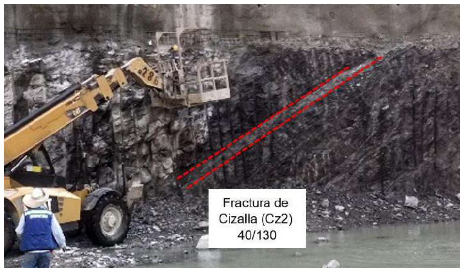
Figura 2-123 Fractura de cizalla Cz2 (40/130) identificada en las Cotas 216,20 a 223,0 Abscisas 559,0 a 570,0; ordenadas -20,0 a -40,0 Fuente: CGI, 2021.
