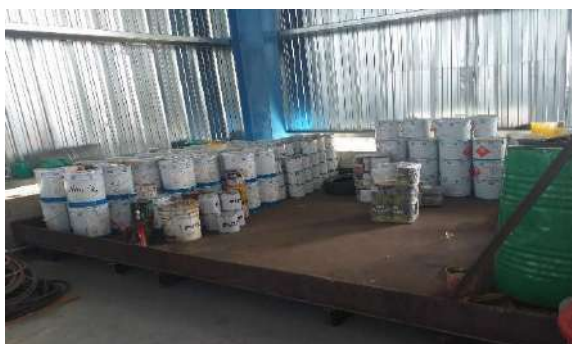
Fotografía 2-14 Dique de contención zona interna
