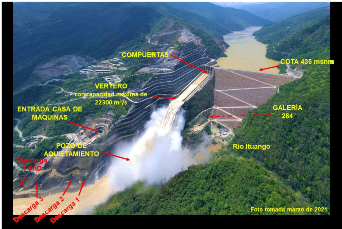
Figura 2-3 Ubicación de las obras principales del PHI.
