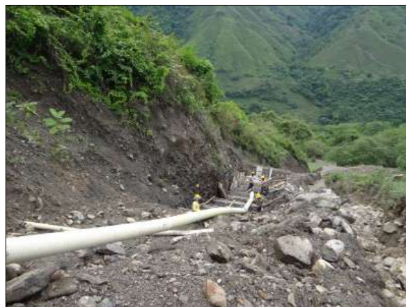
Fotografía 2. Construcción de drenajes en el ZODME Humagá 2.
