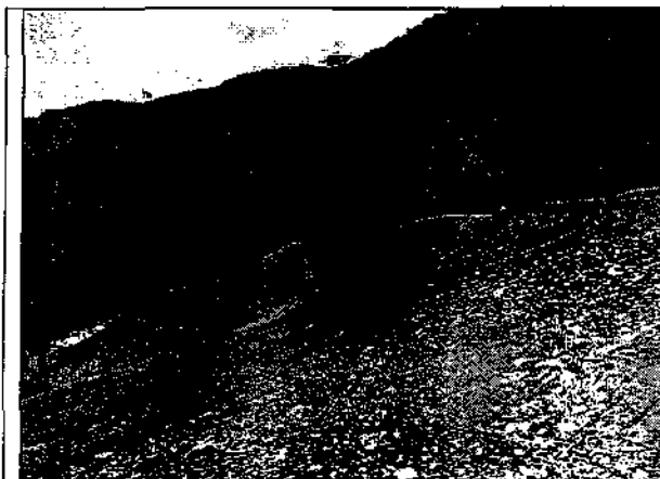
Foto 2. Conformación actual del depósito Ticuita 1, sin obras de revegetalización, sin cunetas entre bermas y con evidencia de procesos erosivos en los taludes.
