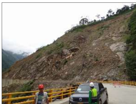
Fotografía 4. Vista del Deslizamiento que se presenta en el puente de Quebrada la Honda, K18+200.
