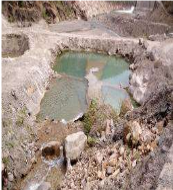
Laguna de almacenamiento y manejo de aguas provenientes del estribo izquierdo de la presa
