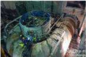
Figura 26 Montaje de tuberías en cámara espiral U2
