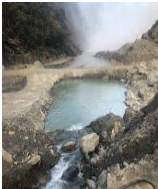
Laguna de almacenamiento y manejo de aguas provenientes del estribo izquierdo de la presa
