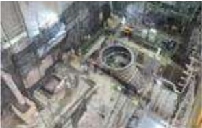
Figura 27 Montaje del tubo de aspiración U3 Fuente: radicado 2021285108-1-000 del 29/12/2021
