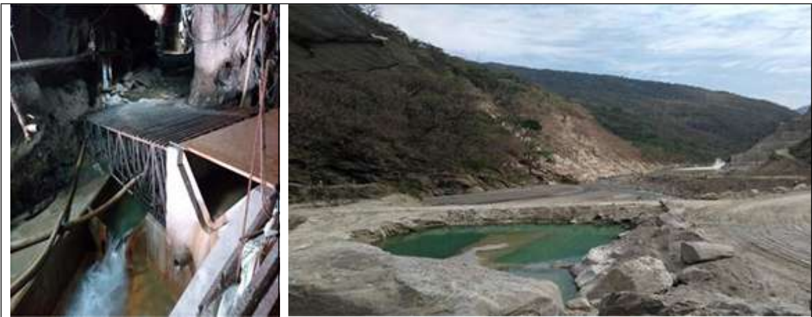
Descarga aguas de infiltración costado izquierdo presa. Fuente: Grupo ANLA.
