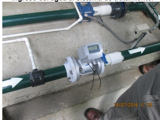
Fotografía 05. Caudalímetro instalado antes del ingreso del agua al sistema de tratamiento.
