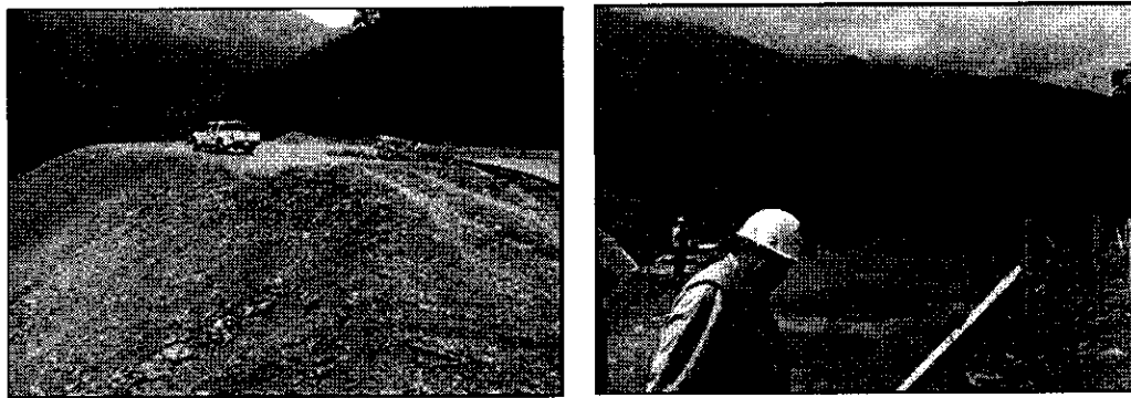
Zona de depósito K12+740
