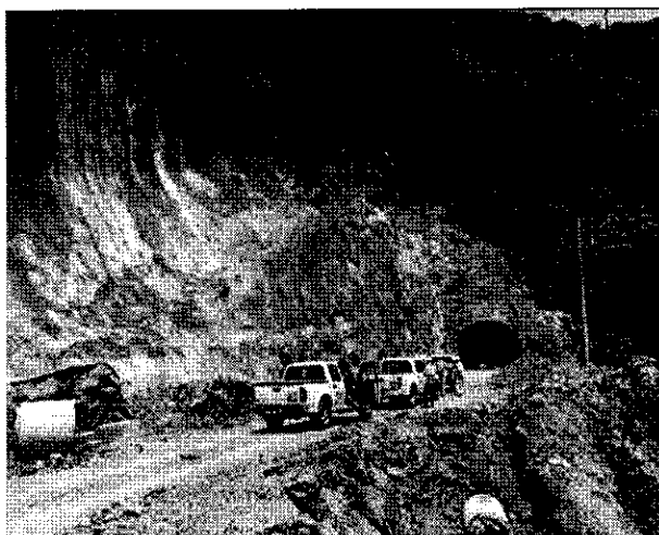
Tratamiento con concreto lanzado y pernos en el talud de aproximación al túnel vial
