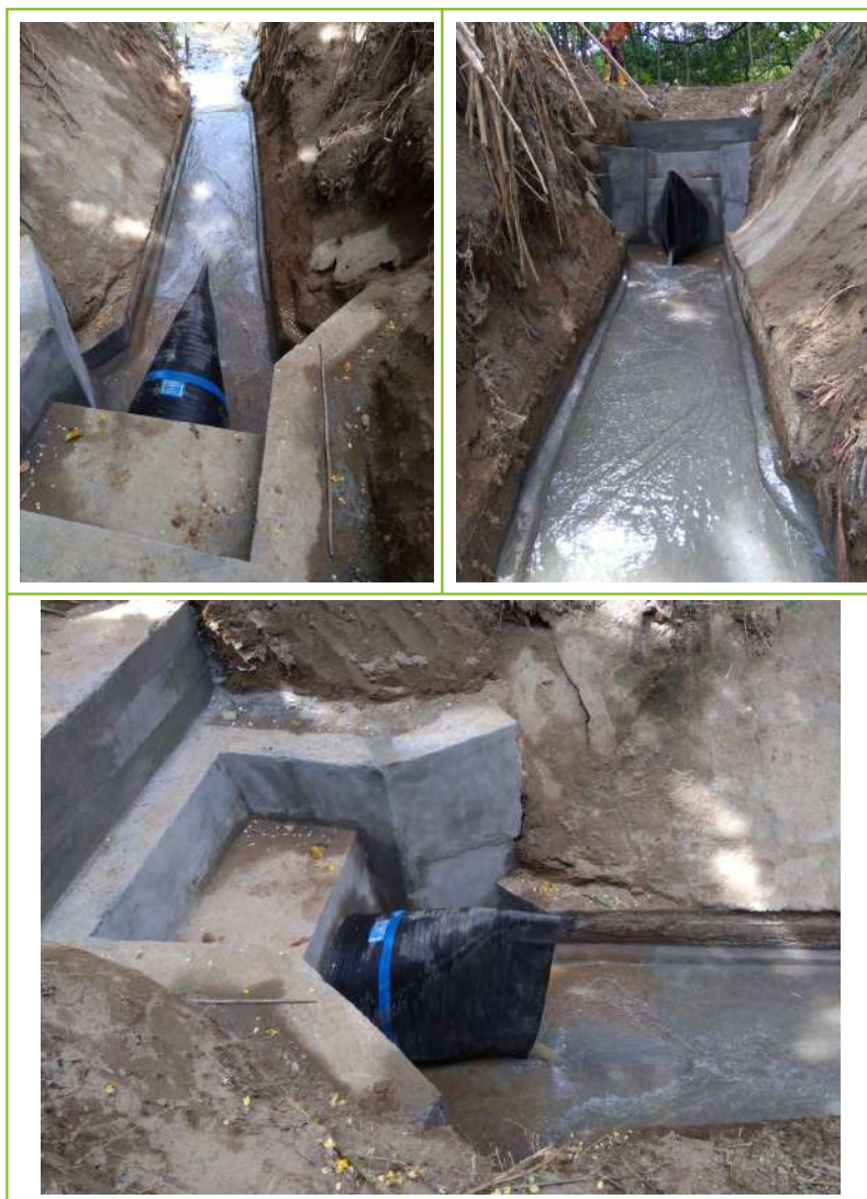
Figura 14. Válvula pico de pato instalada en el barrio Villanueva, Copacabana-Antioquia.
