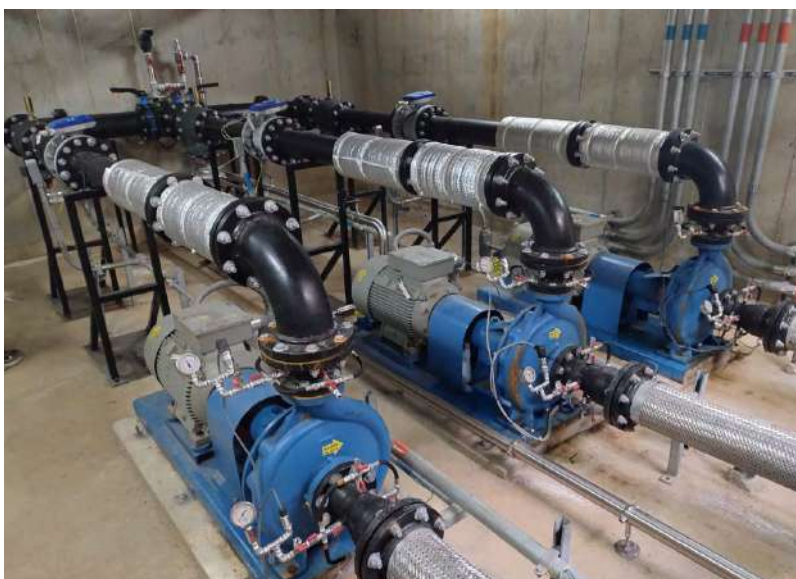
Figura 8. Montaje del Sistema PAT de 75kW en válvula VDE El Dorado (Montaje final).
