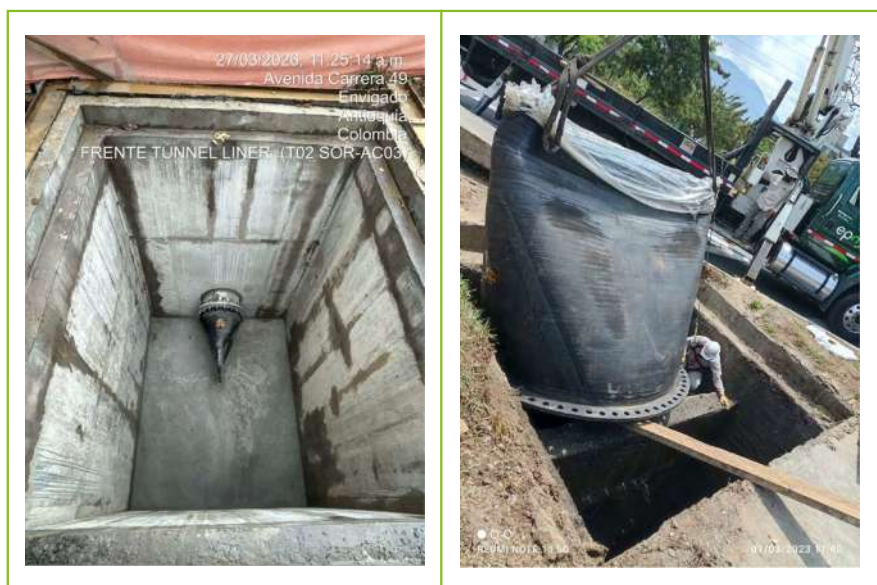
Figura 19. Construcción de caja en concreto reforzado e instalación de válvula pico de pato 600 mm (24") y 2150 mm (85"), Desvío Interceptor.
