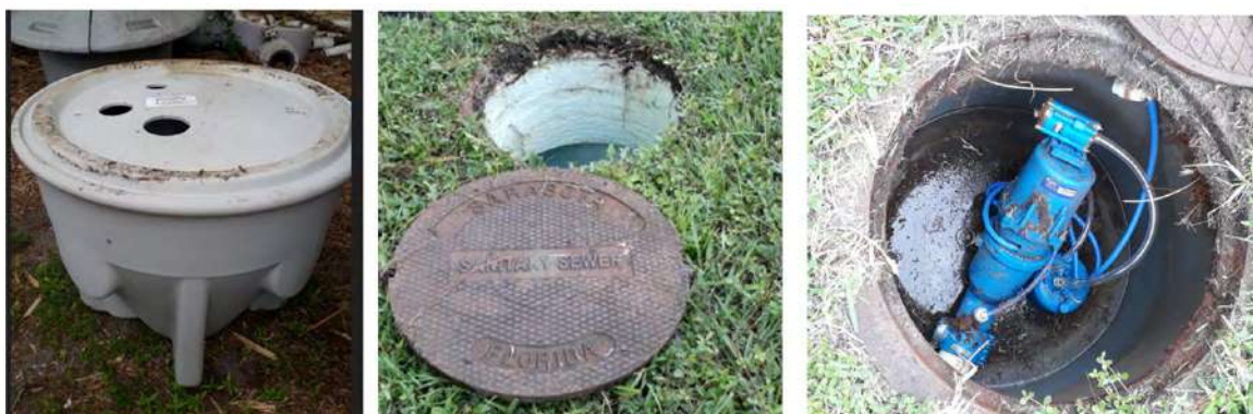
Figura 3. Ejemplos de cajas y de válvula para el AxV, sin instalar e instaladas.
