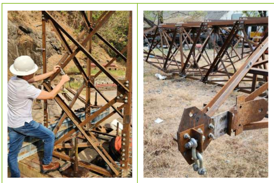
Figura 5. Inspección estructural y geométrico de las torres.
