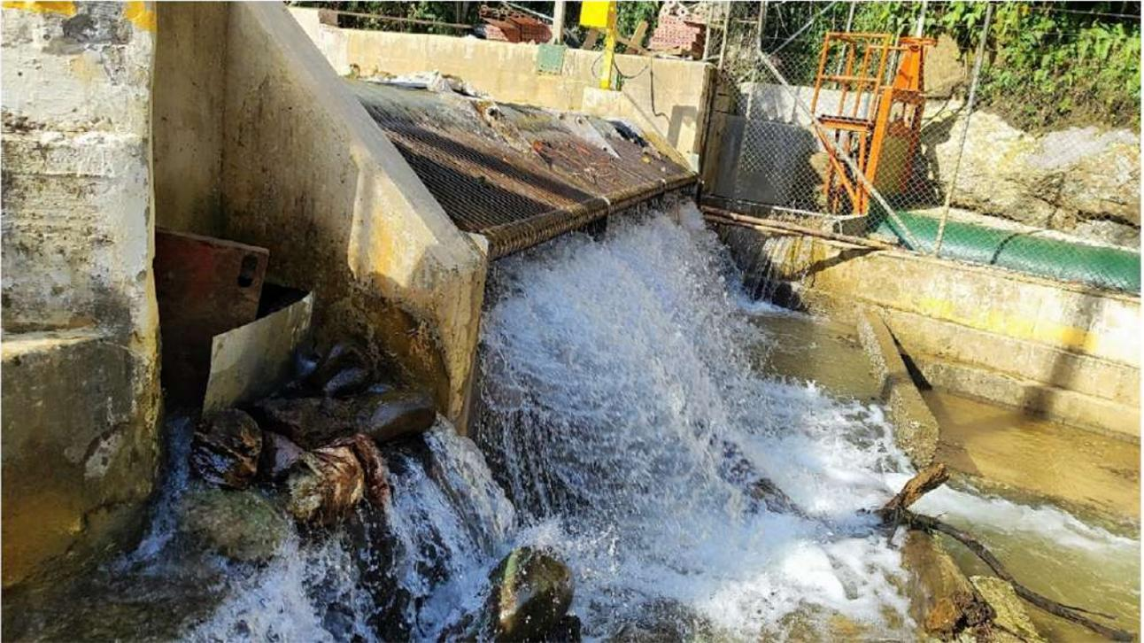
**Figura 18.** Instalación 3 módulos de 1.90 m de largo para la Bocatoma quebrada La Valeria.
