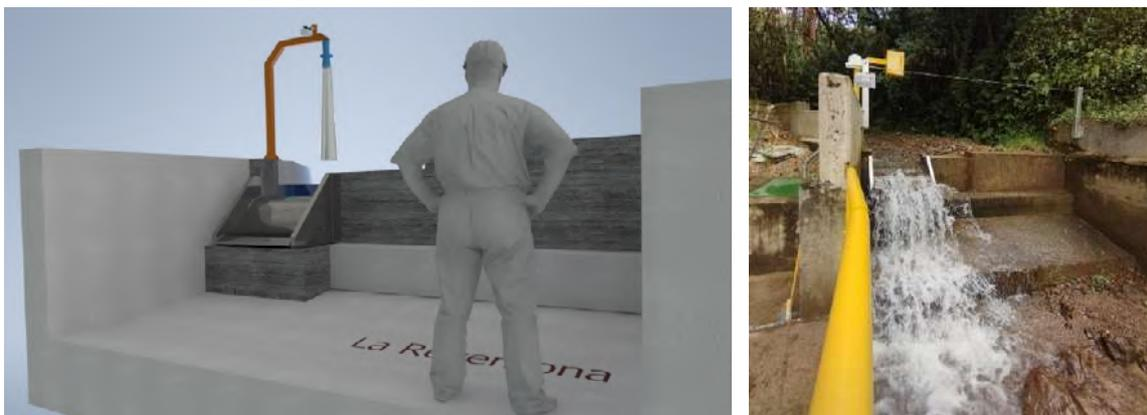
Figura 17. Instalación coanda box Bocatoma quebrada La Reventona.
