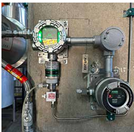
Figura 6. Medición de H_2S a la salida de filtros.
