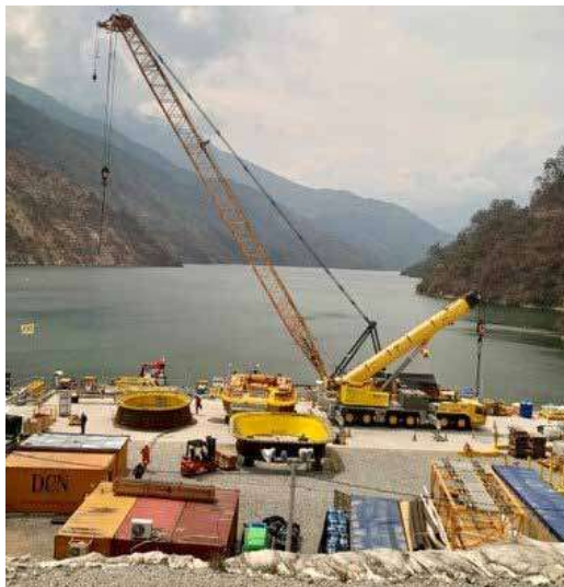
Figura 4. Ensamble de anillos de tapón.
